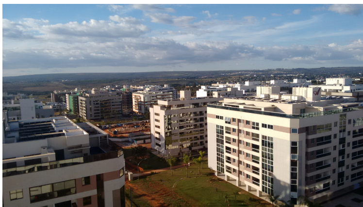
Figura 4: Blocos de apartamentos no Setor Noroeste em 2016: seis pavimentos, assentados sobre pilotis, como no modelo original de superquadras (© Januzzi)
