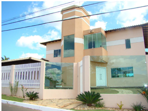
Figura 3: Casa dentro de condomínio em processo de regularização, na região do Grande Colorado, em junho de 2009 (© Patriota de Moura)
