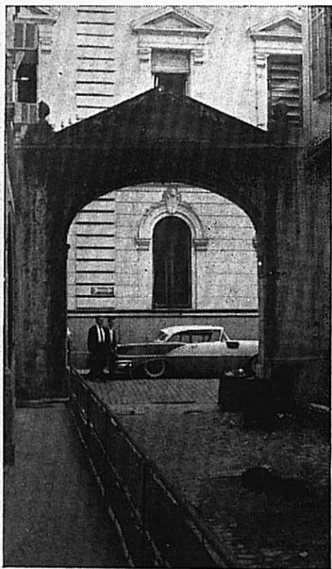
Foto 3 — Vista do estado atual do imemorial Beco do Colégio ou do Pintc.
