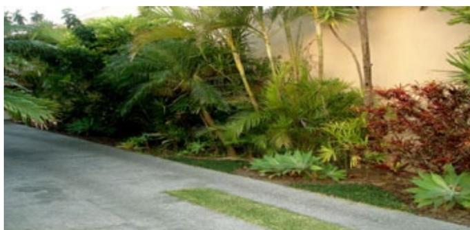
**Figuras 11, 12 e 13:** Visão atual de drenagem urbana com utilização de medidas alternativas: piso semipermeável, telhado verde e passeio com canteiro vegetado. Fonte: Disponível em: <[www.macalester.edu/.../pavement.htm](http://www.macalester.edu/.../pavement.htm)>; <http://blog.nwf.org/2012/10/green-roof-new-york-school/>> e <[http://blogtarrapreta.blogspot.com.br/2012\\_01\\_01\\_archive.html](http://blogtarrapreta.blogspot.com.br/2012_01_01_archive.html)>. Acesso em 28 nov 2013.
