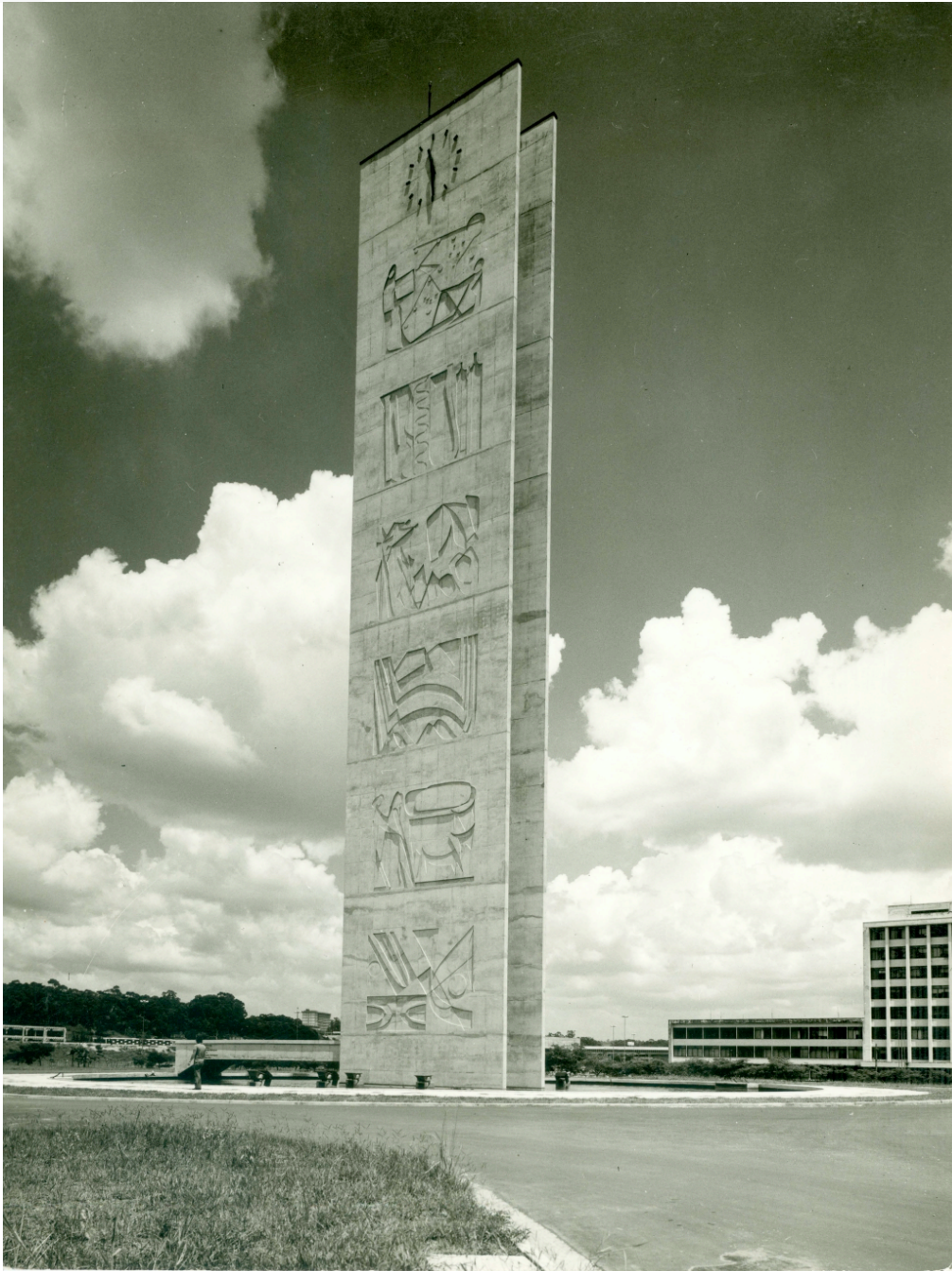
Figura 8: Rino Levi Arquitetos Associados. Torre no Centro Cívico da Cidade Universitária Armando de Salles Oliveira, Praça do Relógio (USP), s.d. Fonte: Acervo da Biblioteca da FAUUSP
