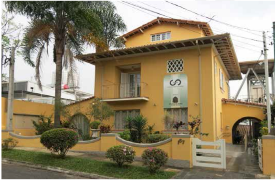
Figura 2 Fachada da Casa Guilherme de Almeida no bairro do Sumaré, São Paulo. Recente reforma, no ano de 2011, equipou a casa-museu de um elevador para tornar o pavimento superior acessível, obedecendo à norma brasileira NBR9050. O acesso à mansarda, entretanto, ainda permanece restrito. (Foto do autor)
