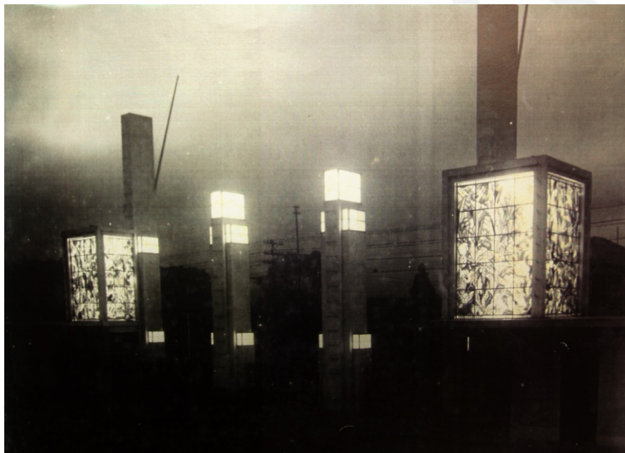
Figura 3 - Foto de vista noturna feita dentro do parque mostrando o Portal de entrada, os cubos com os vitrais instalados e iluminação interna acesa, além das luminárias aplicadas aos elementos verticais. Fonte: Arquivo do Parque Fernando Costa, S.A., 1940.
