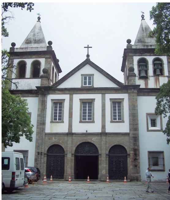
Fotografía 7. Fachada del monasterio benedictino de São Bento, Río de Janeiro. Trazado por fray Francisco de Frías y construido en la década de 1660
