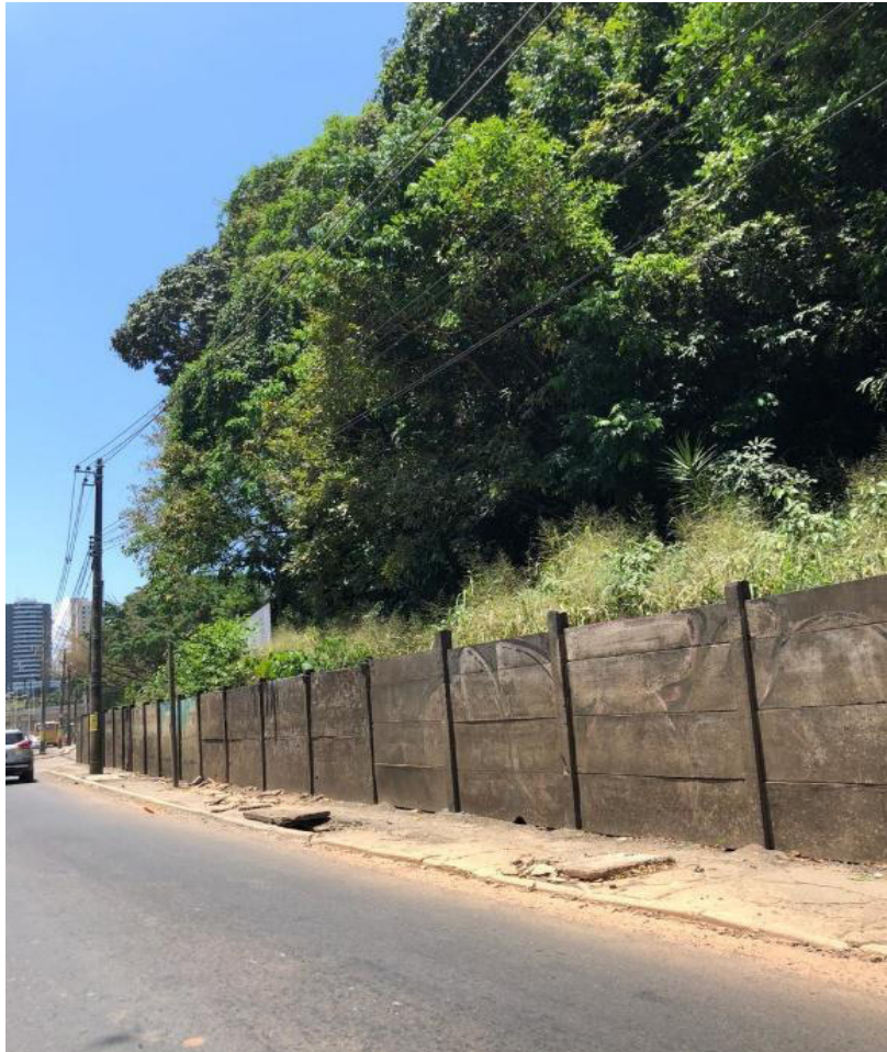
Figura 9 – Calçadas danificadas, estreitas e cercadas por fachadas cegas na Avenida Juracy Magalhães Júnior. Foto: Tadeu Barradas Badaró, 2020.
