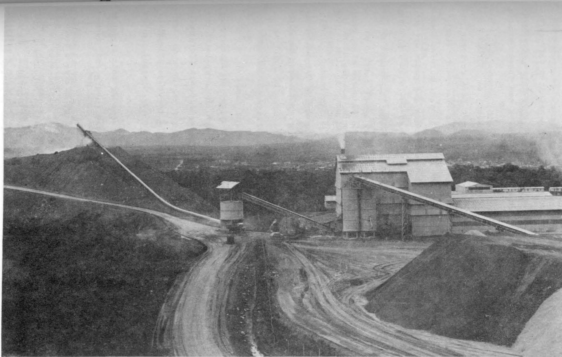
Foto nº 16 - Usina de tratamento, com dois silos de minério seco (ao lado do prédio) e evacuação de rejeitos (a esquerda).
