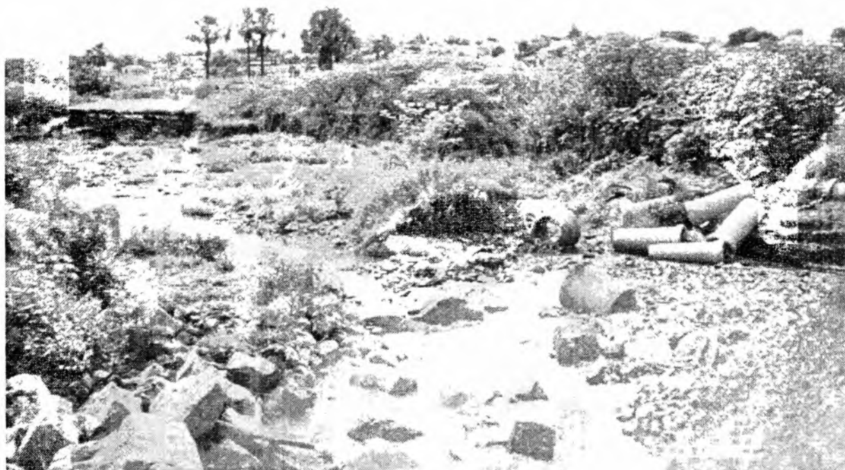
Foto 6 –Fundo de vale do córrego Lagoinha onde são observados o resultados de um inadequado planejamento da localização do sistema de transmissão de esgotos, que foi destruído pelo canal fluvial após eventos pluviométricos intensos. Foto Ricardo R. Alves (2001)
