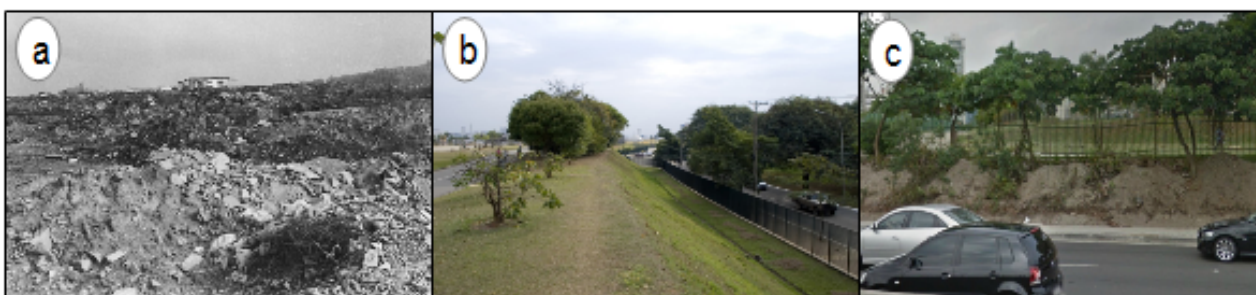
Figura 10 – Parques urbanos e aterros: (a) depósitos antropogênicos que compõem o aterro do Parque Villa Lobos; (b) talude de 3 a 4 metros do Parque Villa Lobos; (c) Aterro do Parque do Povo
