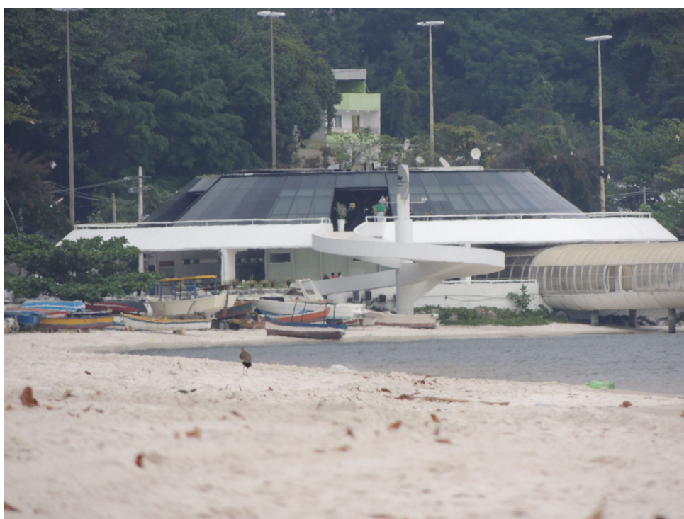
[Figura 5] Estação Hidroviária de Charitas
