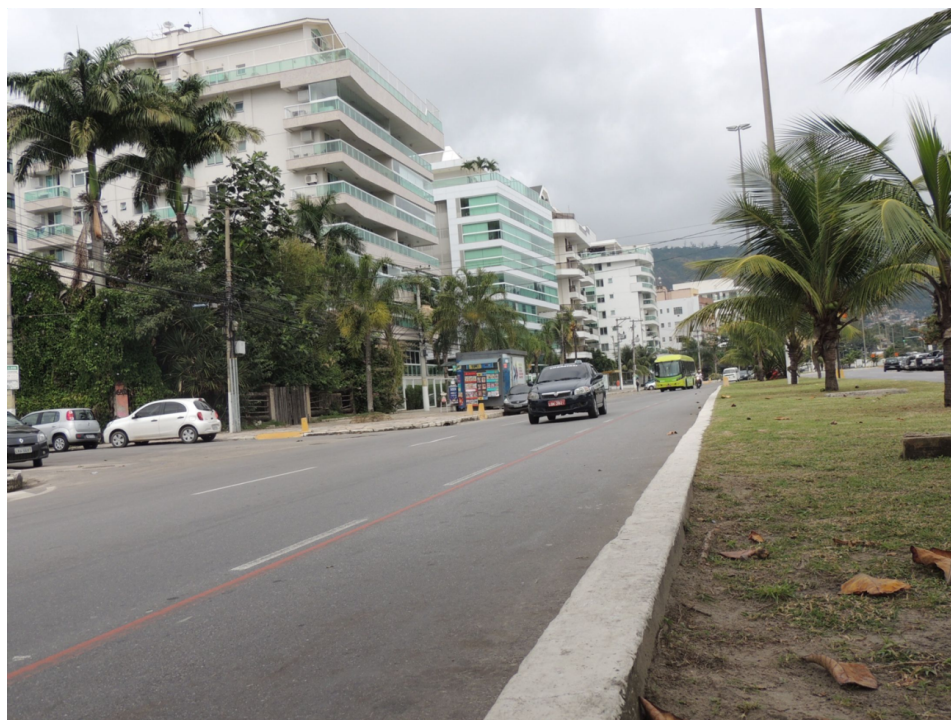
[Figura 7] Bairro de Charitas: novas edificações no entorno da Estação Hidroviária
