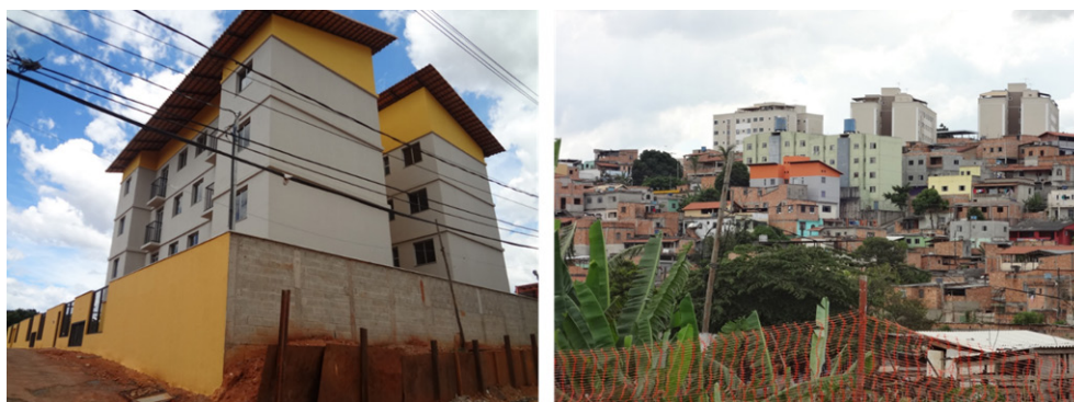
Figura 06 Entrega das primeiras Unidades Habitacionais. Destaque para o impacto gerado na paisagem urbana local, dado que modelo de habitação construído pelo empreendimento destoava enormemente do padrão construtivo local, implicado pela desconsideração dos aspectos socioculturais das moradias pela política governamental. Fonte: Autores, Março 2014.
