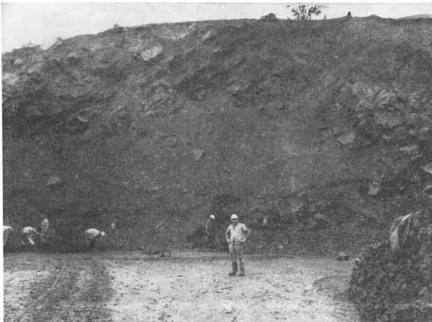
Foto 2 — Vista parcial mostrando uma das frentes de trabalho.
