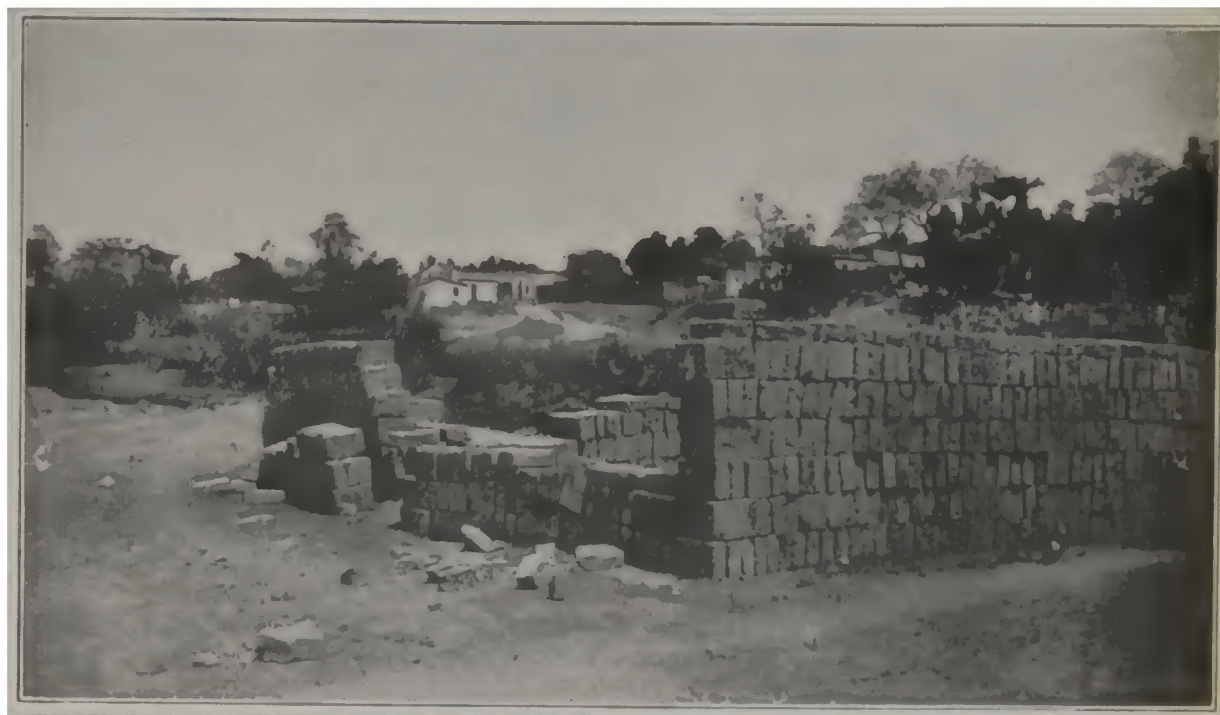
Fabricação de tijolo crú (adobe) nos arredores de Cuiabá (Várzea)
