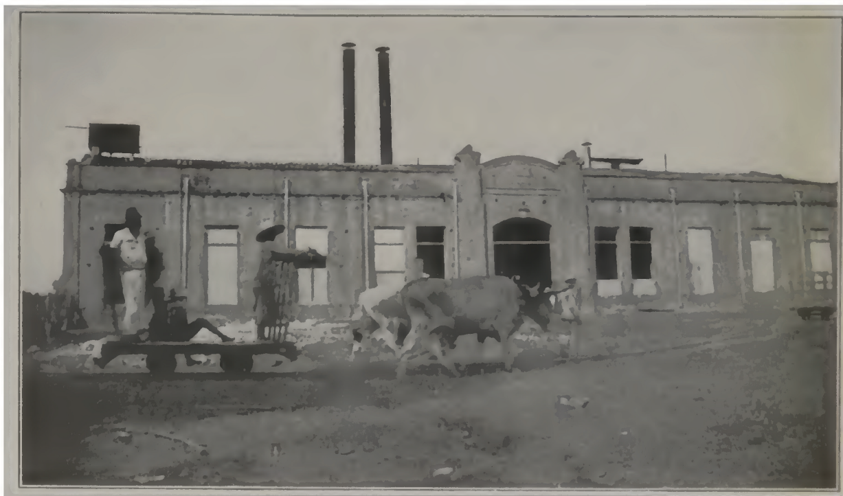
Usina Santo Antônio
