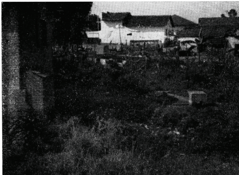
Fig. 3 — Privada com fossa negra em nível superior ao poço. À direita (não aparecendo na fotografia) há outra fossa do vizinho, à menor distância. Rua Américo Brasiliense.
