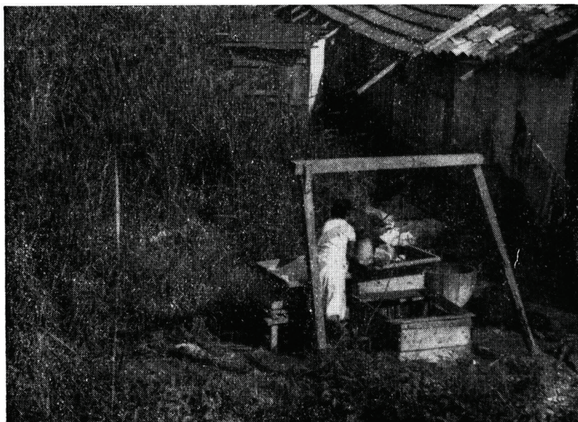
Fig. 1 — “Barraco” situado à rua Américo Brasiliense (parte baixa) abrigando várias famílias. Notar o poço em nível mais baixo do que a fossa negra.
