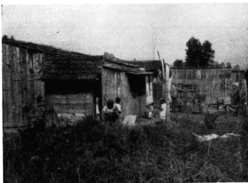
Fig. 7 — Rua Joaquim de Andrade. Outro grupo de “barracos” situado em frente aos da figura 6. Notar o único poço que serve a todos os habitantes desta pequena favela. O terreno baixo apresenta lençol freático muito superficial e a única privada destes “barracos” situa-se em nível superior ao lado da fotografia.
